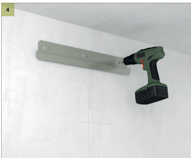
Boor de gaten en installeer het wandbevestigingsprofiel.
