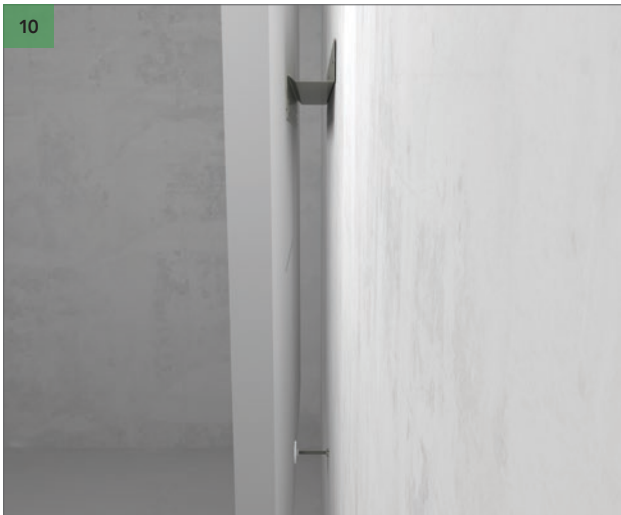
Plaats uw Rockfon Eclipse wandpaneel op het wandbevestigingsprofiel en pas de afstandshouder aan tot het Eclipse wandpaneel waterpas hangt.
