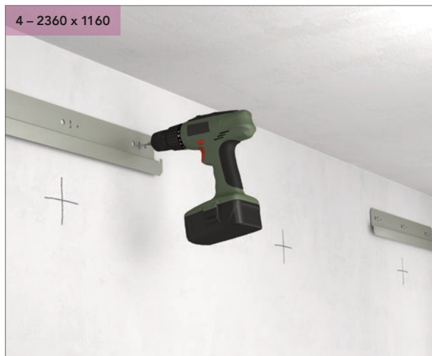
Boor de gaten en installeer het wandbevestigingsprofiel.
